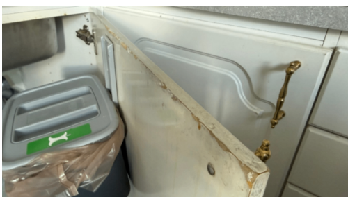
Skader på skapdør.
