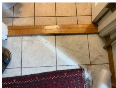
Sprekker i fliser spisestue
