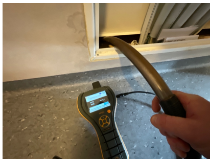
Bildet viser måling av fuktinnhold i treverk/bunnsvill inni vegg litt dusj. Målingen er tørr.
