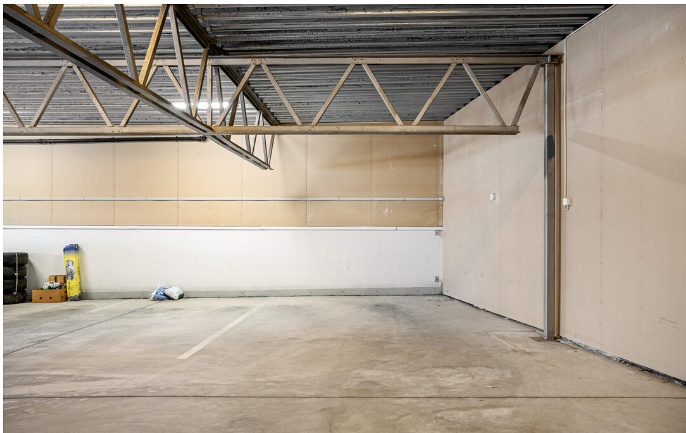
Parkering i lukket garasjeanlegg.
