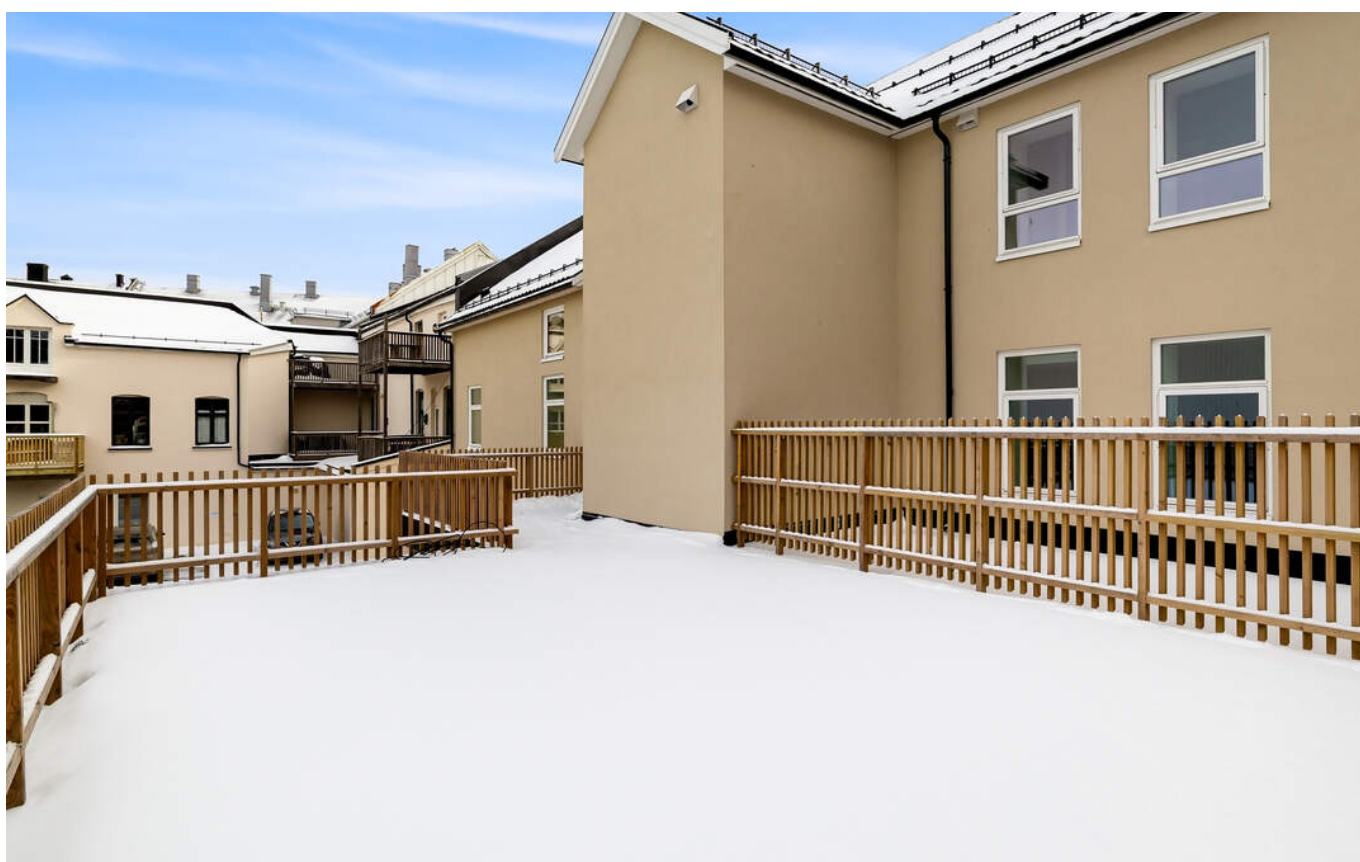
Stor, felles takterrasse med utgang fra 2. etasje.
