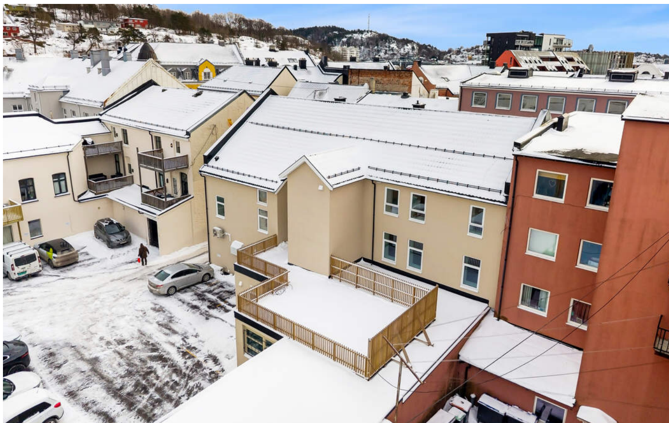
Stor, felles takterrasse med utgang fra 2. etasje.
