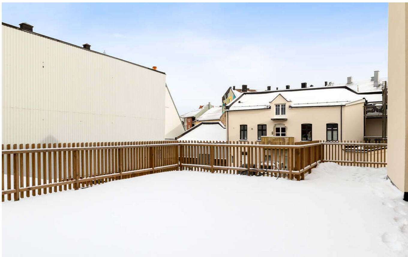
Stor, felles takterrasse med utgang fra 2. etasje.
