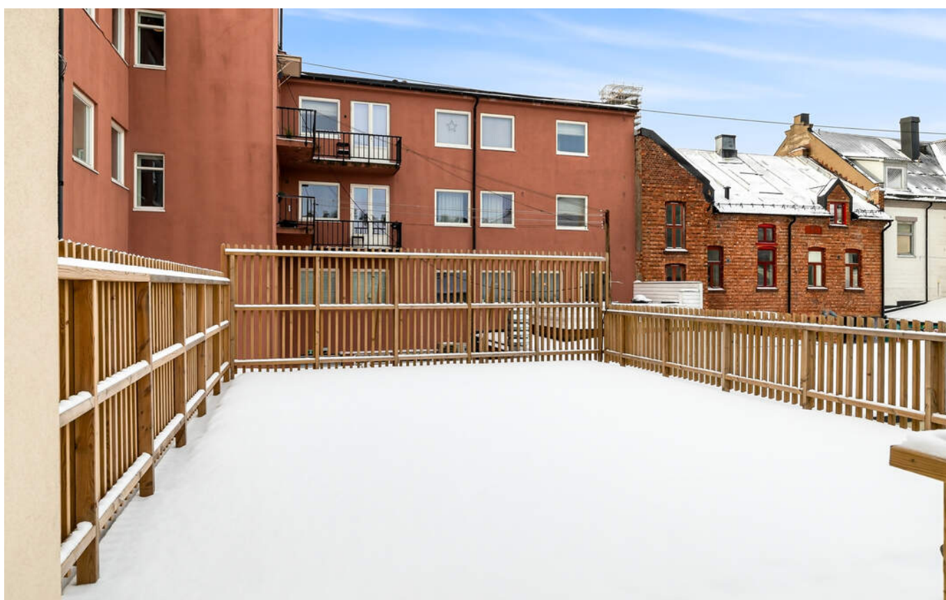
Stor, felles takterrasse med utgang fra 2. etasje.
