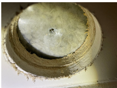
Diffusjonssperre/plast i utforet vegg under terreng
