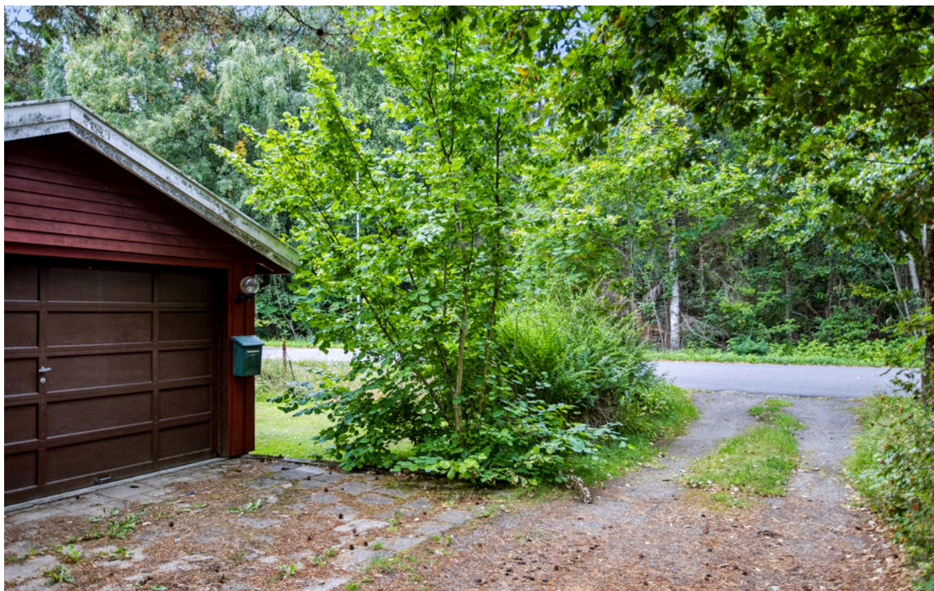
Garasjen er utstyrt med leddport med elektrisk portløfter. Det gjøres oppmerksom på at portløfteren er defekt.
