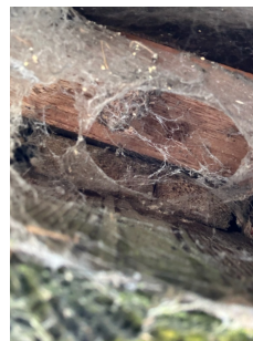
Treklosse under overslag enkelte steder.
