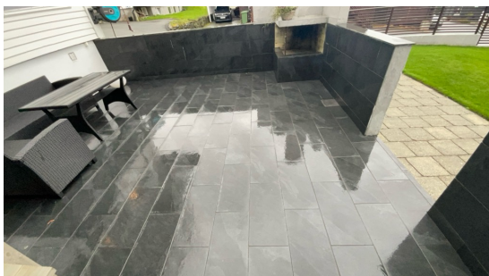
Fliselagt terrasse med løse fliser.
