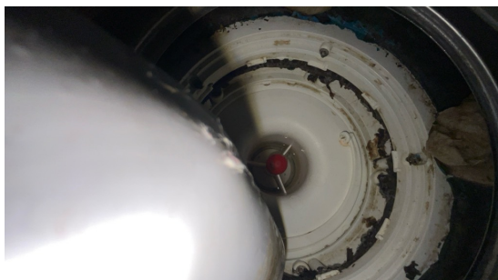
Membran ned i sluker med klemring.
