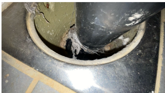
Smøremembran ned i sluk.
