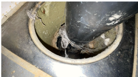
Smøremembran ned i sluk.
