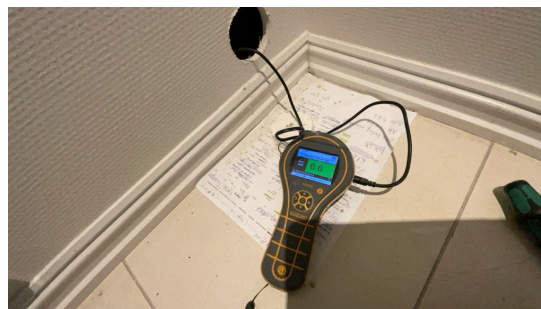
Hulltaking er utført i hjørne stue U et, og helt tørt.
