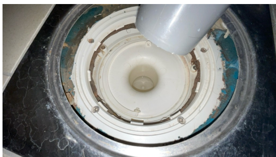
Membran ned i sluker med klemring.
