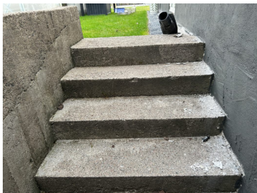
utvendig støpt trapp
