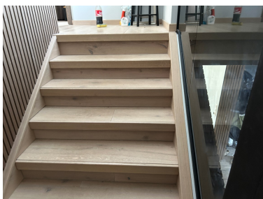
trapp mellom 1. og 2.etg
