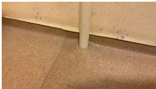
Rørgjennomføring i gulv/vinylbelegget.
