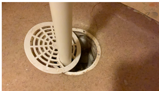
Sluk i gulv.
