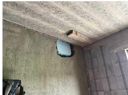
Stort hull i yttervegg mellom yttervegg og garasje.
