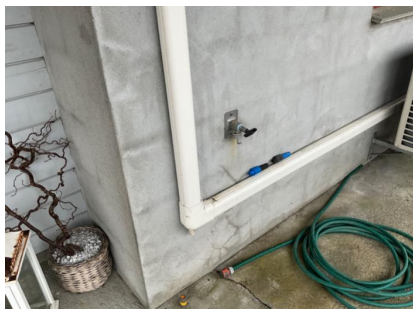
Vannuttak ved hovedinngang
