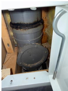
Avløpsrør sett via stakeluke på bad, underetasje.
