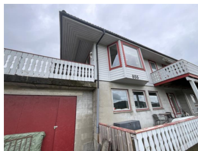
Takrenner og nedløp i plast.
