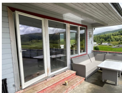
Terrassedør med helt, isolert glassfelt montert i trekarmer
