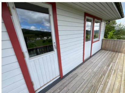
Altandør med utgang fra kjøkken (nærmest) og altandør med utgang fra soverom.
