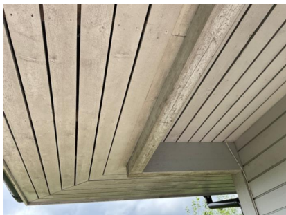
Montert fluenetting i luftespalter.
