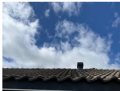
Valmet yttertak, tekket med betongtakstein.
