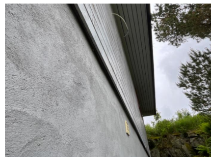
Yttervegg, gavlvegg mot nord.
