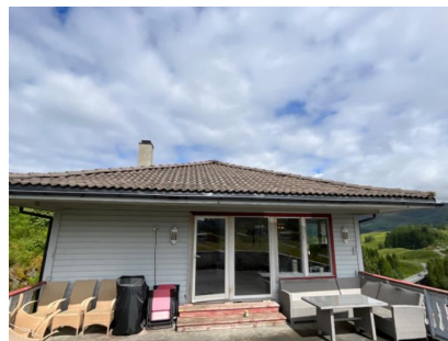
Valmet yttertak, tekket med betongtakstein.
