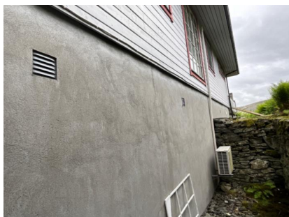
Lufteventiler i yttervegger.
