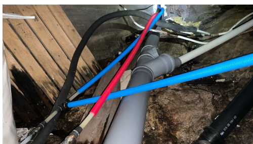
Rør i krypkjeller
