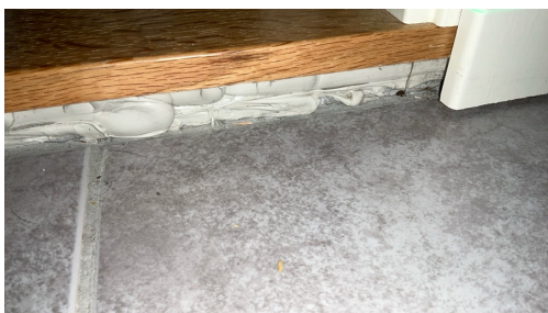
Fuging under dørterskel
