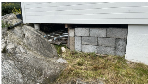
Terreng ved tilbygg vest
