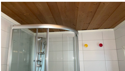
Oversikt vegger og tak
