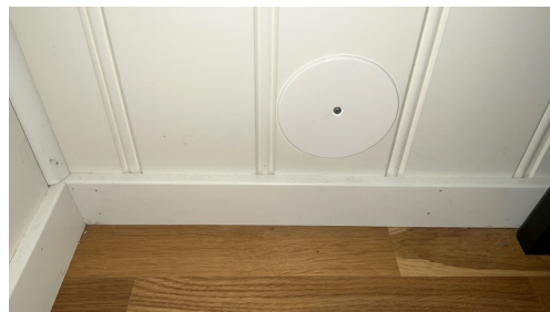
Dekkløkk montert etter hulltaking
