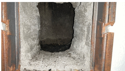
Pipeløp sett fra sotluke
