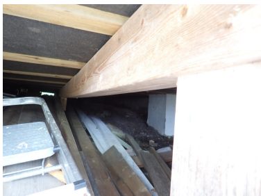
Bæredrager under tilbygg vest
