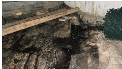
Vann på fjell i krypkjeller mot sørvest
