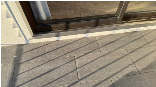
Det er ikke kjent tekkemateriale under flisene.
