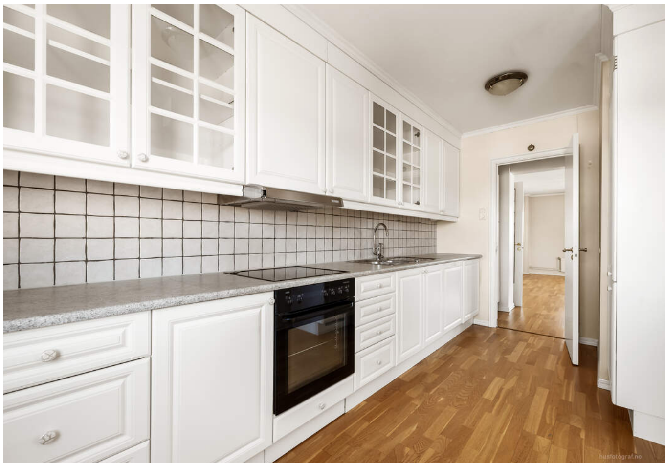
Vegg over benkeplate er flissatt for enkelt renhold, og avtrekk er koblet til byggets sentrale anlegg.
