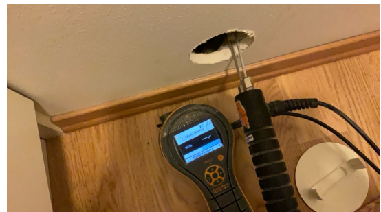
Fuktsøkt i vegg uten unormale forhold.
