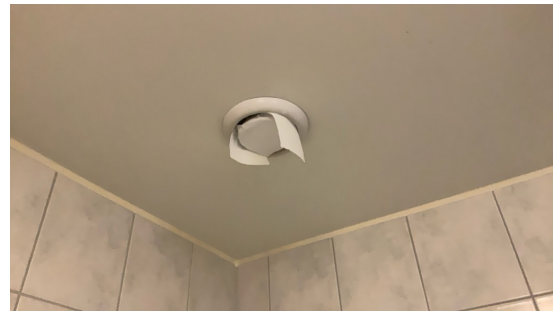
Avtrekk funksjonstestet med papir.
