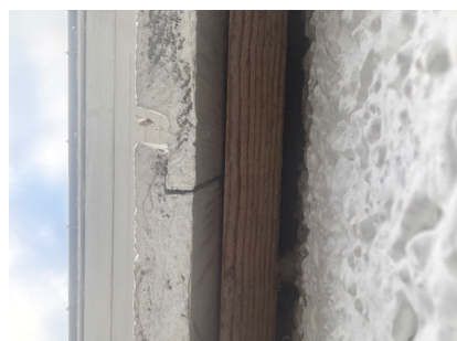
Brukt horisontalt liggende lekt i bunn av kledning.
