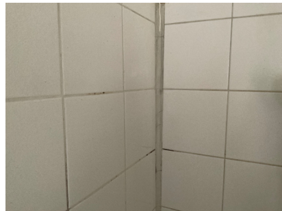
Det er benyttet flisefug av ikke elastisk masse i hjørner og andre overganger.
