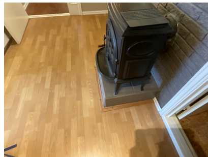
Manglende plate foran ovn i underetasje.
