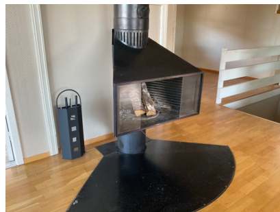
Løse glass på peis, ikke mulig å stenge helt i front.
