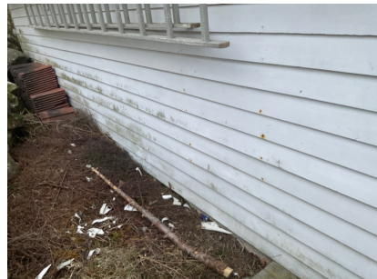
Kledning har blitt avsluttet nedtil bakken
