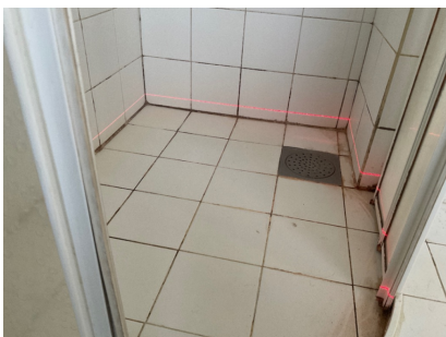
Slukrist høyeste punkt. Vann ansamling vil forekomme ved dør 5mm motfall
