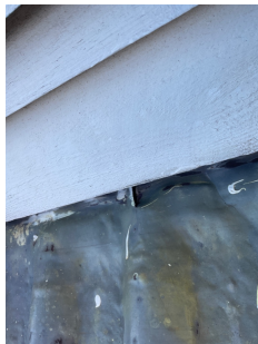
Det har oppstått noen sprekker i bly rundt på taket.
