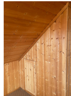
Pipe er innkledd med trepaneler på loft.
