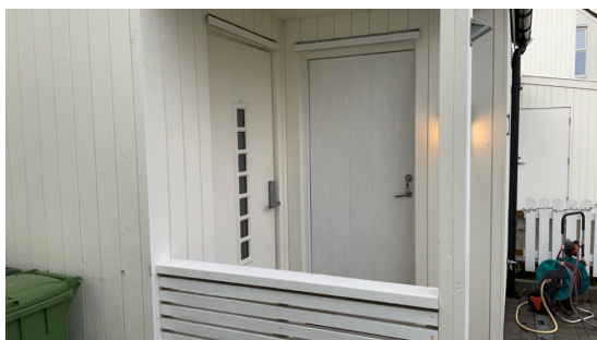
Nyere hovedytterdør, eldre boddør.
