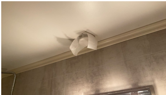
Avtrekk testet med papir.
