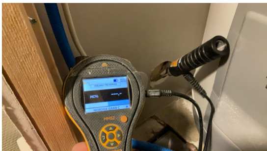
Fuktsøkt i vegg uten unormale forhold.
