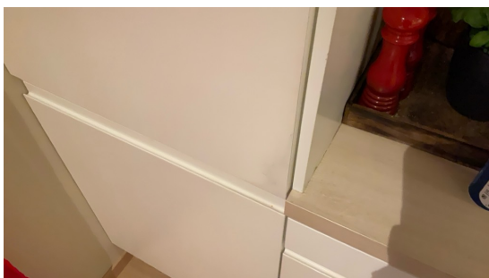
Bruksslitasjer, her på kjøleskapsdør.
