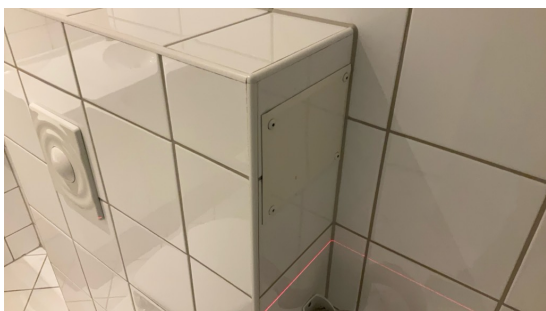
Luke med tilgang til kasse for sisternen på toalett-kassen.
