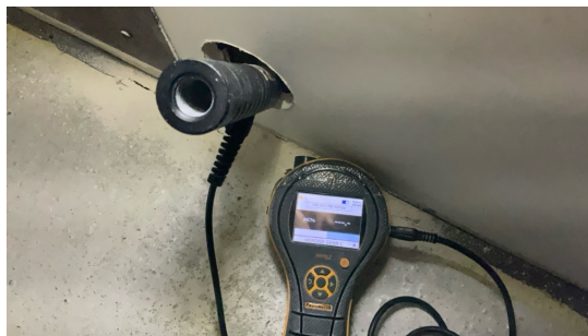
Fuktsøkt i vegg uten unormale forhold.
