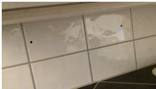
Hull etter tidligere oppheng
