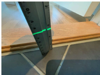
Gulv ved terskel
