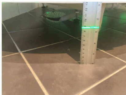
Gulv ved dusjkabinett
