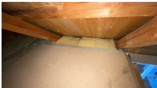
Isolasjon mot undertaket (ikke luftspalte).
