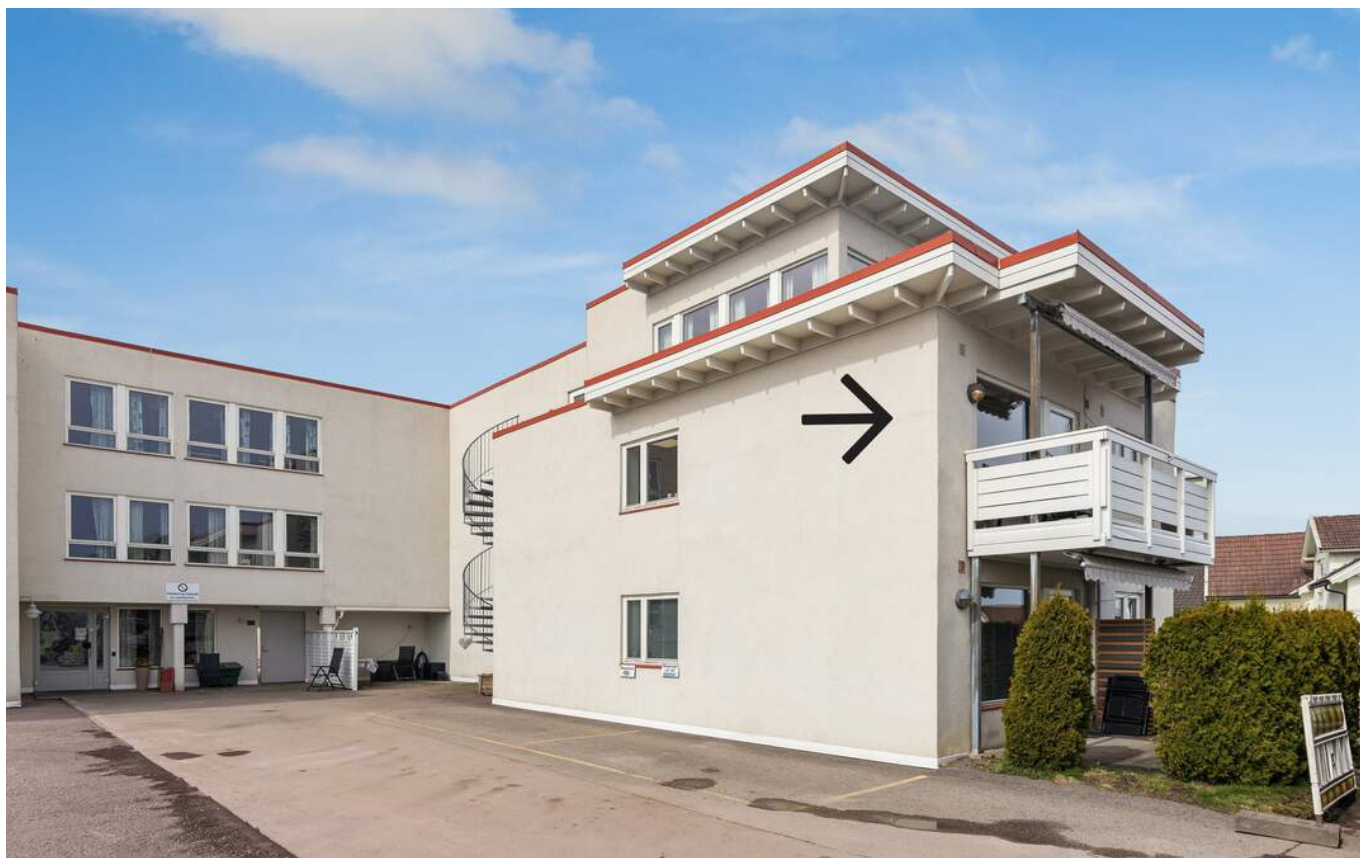
Felles inngangsparti m/porttelefon. Pilen viser beliggenheten til leiligheten.
