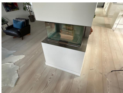
Det mangler ildfast plate på gulv foran ildsted i stue.
