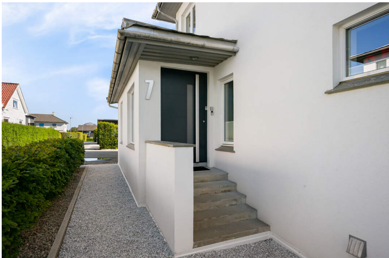
Takoverbygget inngangsparti for gjestene.
