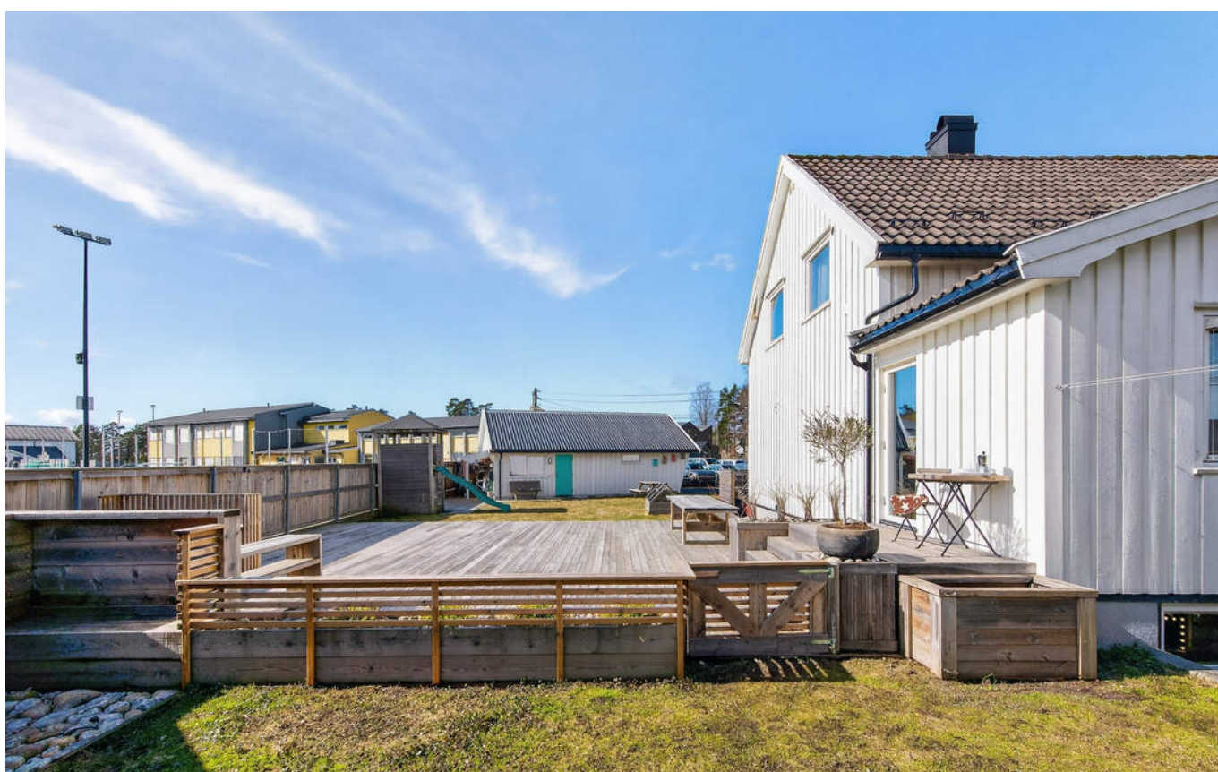
Inngjerding mot plattingen
