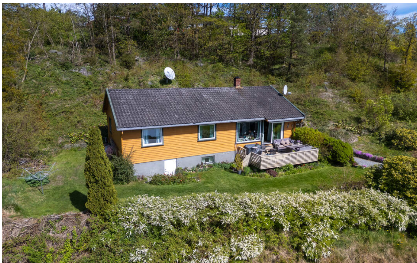
Klassisk enebolig fra 60-tallet, påbygget i 1977
