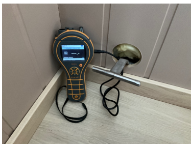
Fuktmåling uten utslag.
