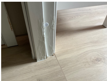
Dørkarm med fugemasse.
