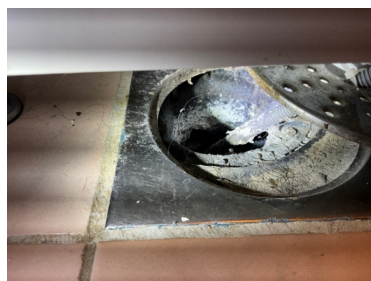
Oversiktsbilde av sluk.
