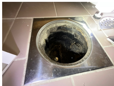
Oversiktsbilde av sluk.
