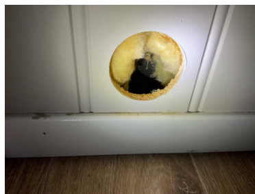
Bruk av forhudningspapp bak påforetvegg av grunnmur.
