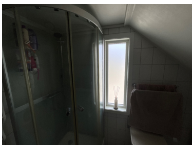
Vindu i dusjens våtsone.
