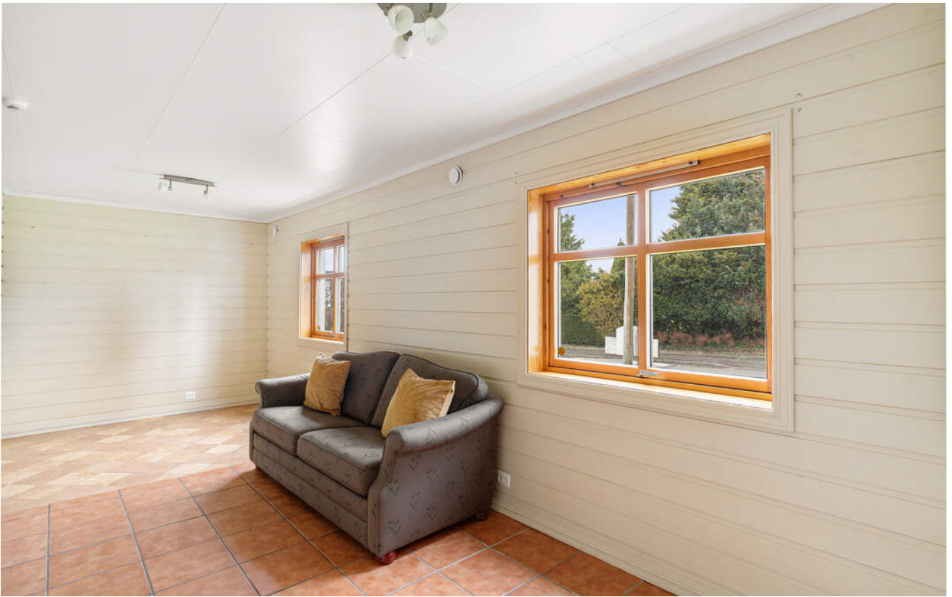
Kjellerstue / soverom i underetasje. Opprinnelig inndelt som to rom; tekjøkken og soverom på originale tegninger.
