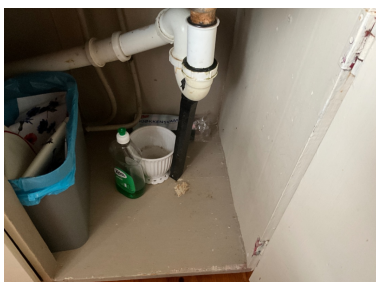
Avløpsrør som er understøttet.
