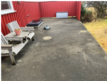
Betongplating uten tettesjikt.
