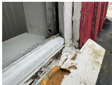
Råteskadet vinduskarm.
