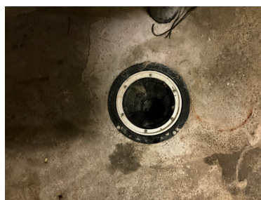
Oversiktsbilde av sluk.
