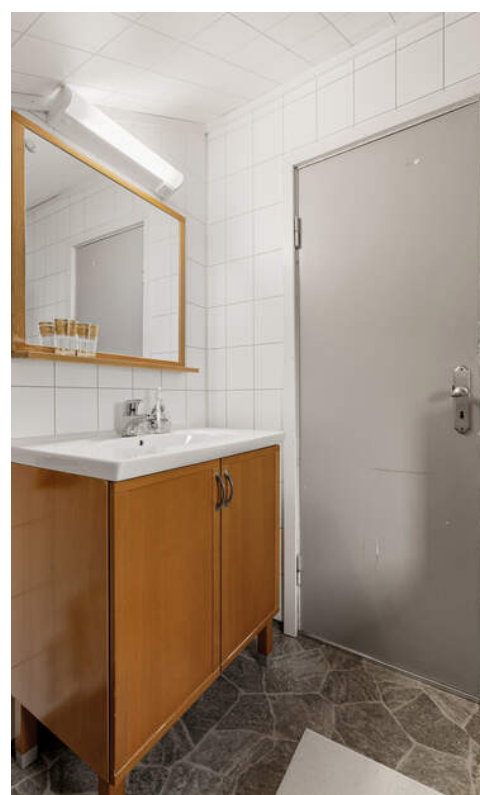
Vinylbelegg på gulv og baderomsplater på vegg og tak.
