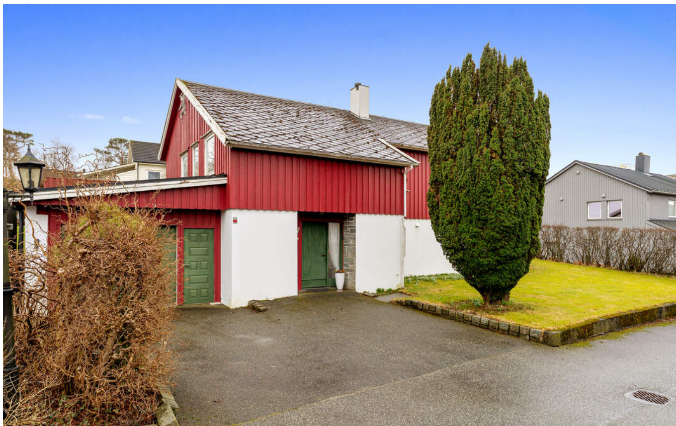
Påbygg av garasje og lagerrom ble oppført i 1995
