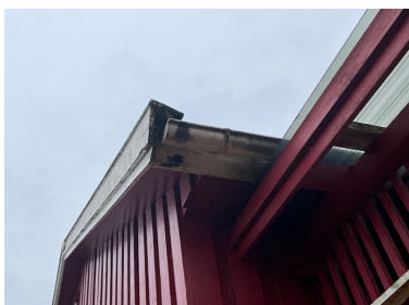
Råteskadet stubord.
