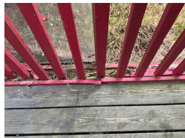
Råteskadet rekkverk.
