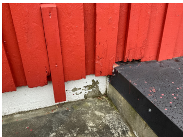
Råteskadet kledning.
