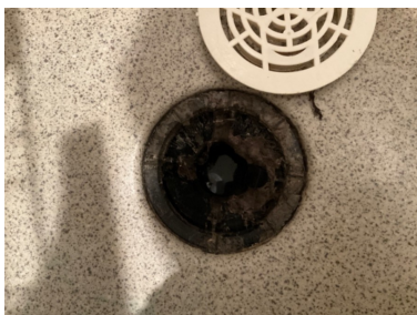
Oversiktsbilde av sluk
