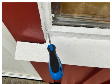
Råteskadet vinduskarm.
