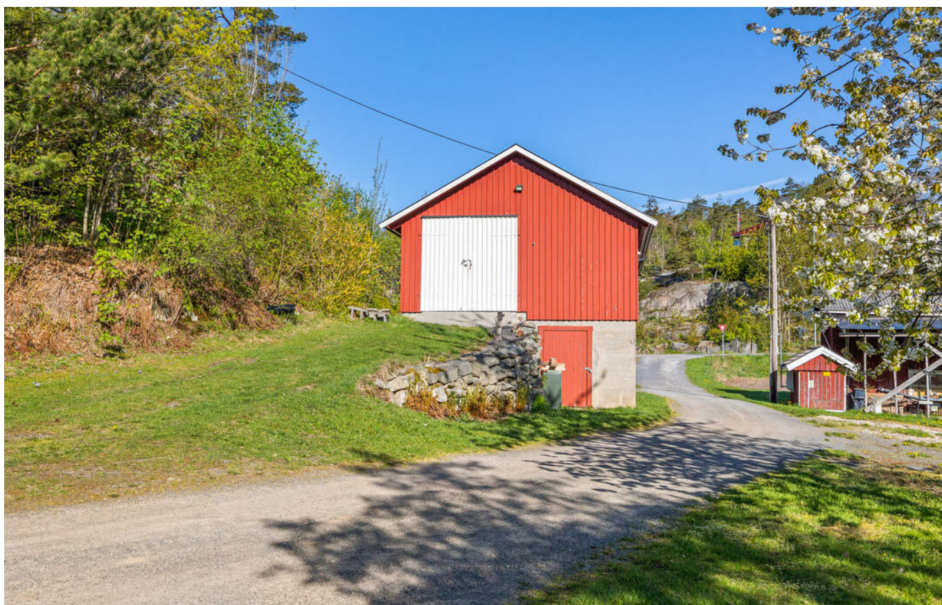
Låve med 2 lagerrom i underetasje og stort rom i 1. etasje.
