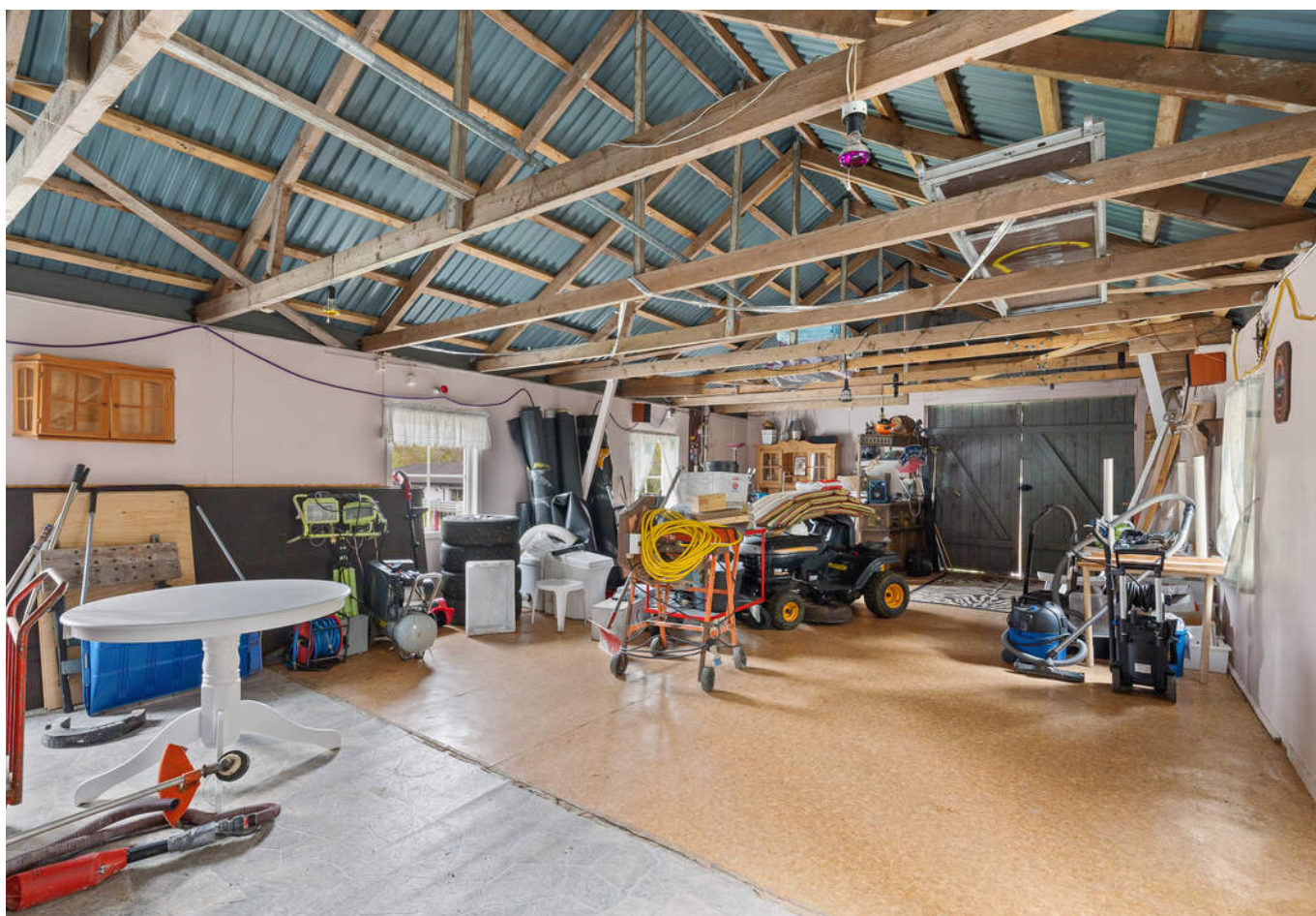
Låver er oppført i tre på mur og kledd med stående kledning. Saltak teknet med stålplater. Dører og port i tre og vinduer i tre. I underetasje er det sikringsskap (hovedskap) til alle bygninger (ikke uthus).
