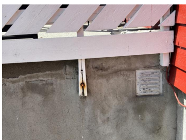
Innfesting av rekkverkstolpe har rust
