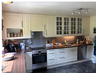
Kjøkkeninnredning er med en malt overflate med profilerte fronter
