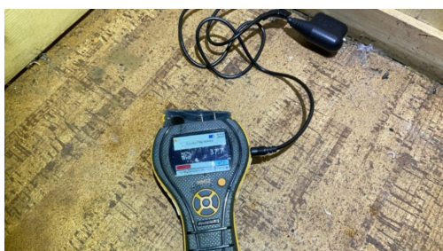
Målt fukt i rom under terrasse
