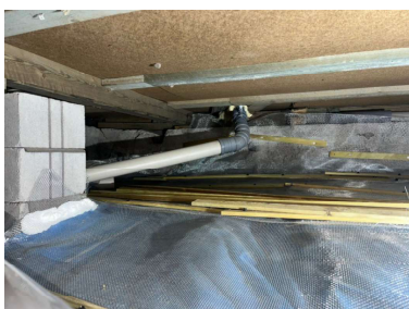
Krypkjeller under stue, gang. Sikret med fuktsperre og netting på bakken.
