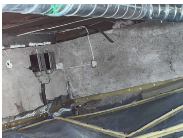
Krypkjeller under stue, gang. Sikret med fuktsperre og netting på bakken.
