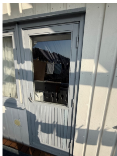
Balkongdøt ut fra soverom, loftsetasje.
