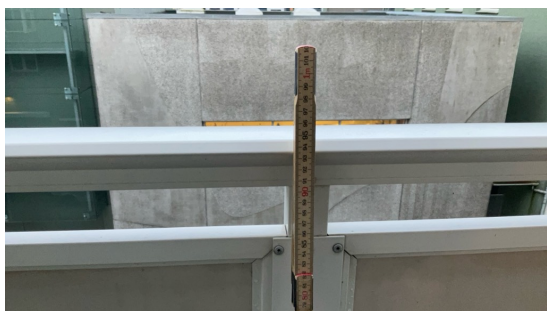
Rekkverk ca 95 cm.
