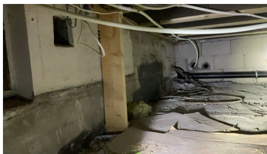
eler av mur sett i krypkjeller.
