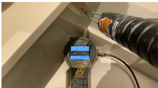
Fuktsøkt i vegg uten unormale forhold.
