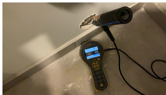
Ingen unormale fuktforhold i påforet yttervegg i teknisk rom.
