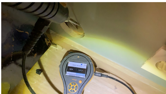
Fuktsøkt i vegg uten unormale forhold.
