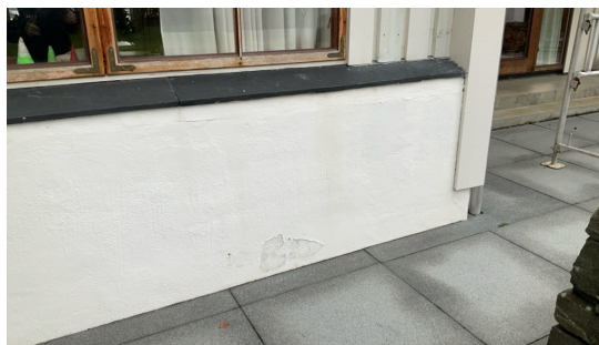
Avflassing på mur ute.
