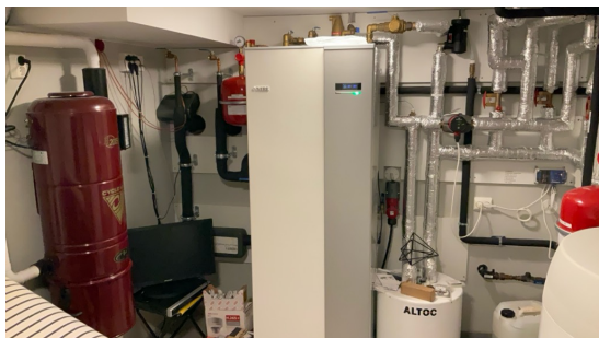
Varmepumpe luft/vann.
