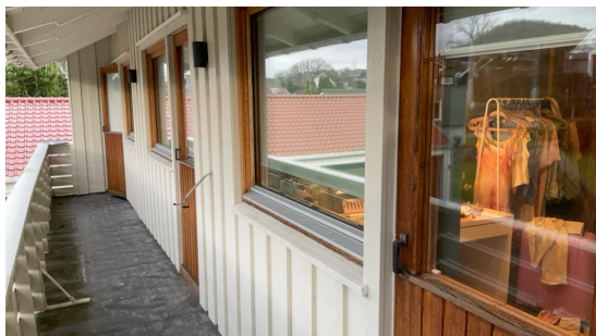
Balkongdører i 2 etg fra 1952.
