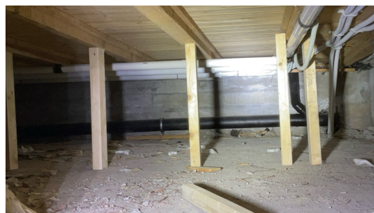
Mer eller mindre provisoriske oppstøttinger av bjelkelaget sett i krypkjellere.
