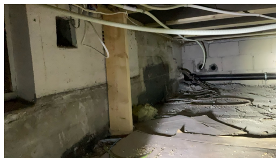
eler av mur sett i krypkjeller.
