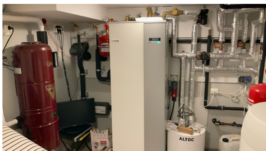
Varmepumpe luft/vann.
