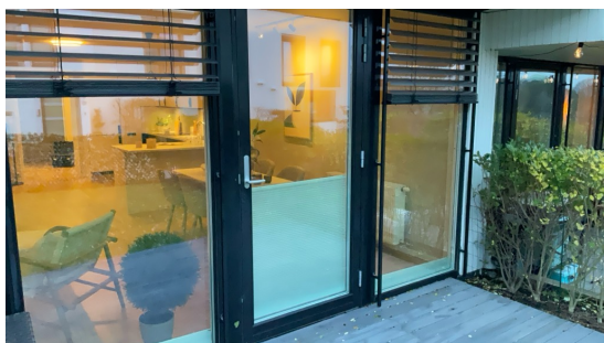
Terrassedør i 1 etg
