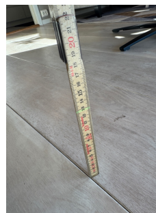
Bildet viser høyeste nivå fra horisontalplanet over lang målelengde i stue/kjøkken.
