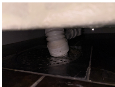
Sluk under dusjkabinett har begrenset tilkomst
