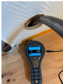
Måling utført i kjellerrom i mot sør-øst, ved hovedvannledning
