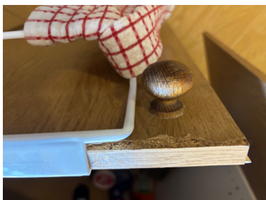
Kjøkken innredning har skader i overflate
