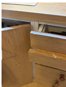
Kjøkken innredning har skader i overflate
