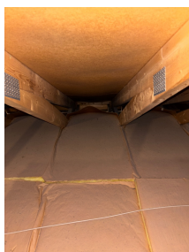
Takkonstruksjon er oppført med takstoler
