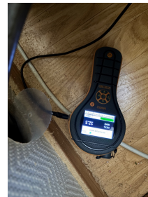
Måling utført i yttervegg i stuen- i leiligheten
