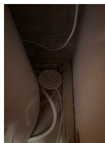
Rom med sluk i kjelleren i hoveddelen
