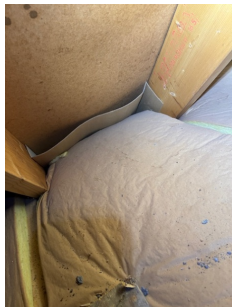
Bildet viser sammenklemt åpning hvor tilluft slippes inn til kaldt loft.
