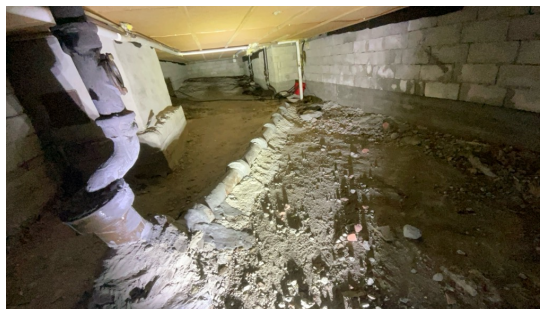
Kryp Kjeller med stubbloftsgulv er tørr og ingen tegn til fukt.
