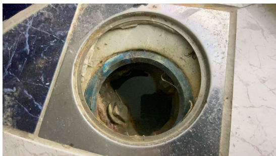
Eldre gulvbelegg ned i eldre stålsluk med klemring.
