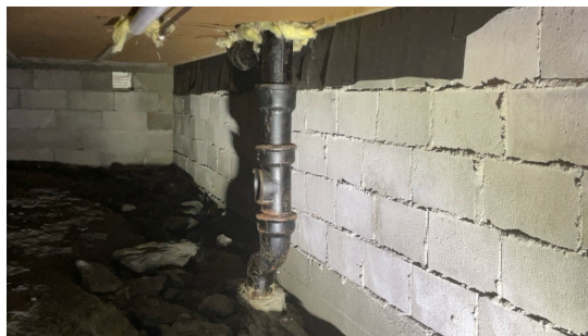
Avløpsrør av støpejern sett fra krypkjeller.
