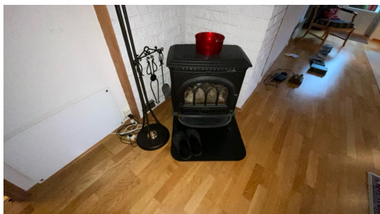
Pipe med brannmur, vedovn og stålplate på gulv.
