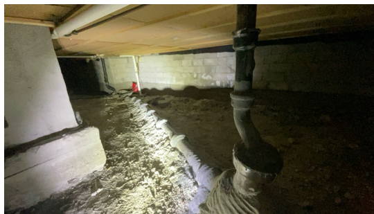
Avløpsrør av keramikk og støpejern sett fra krypkjeller.
