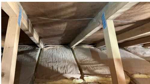
Det er begrenset lufting
