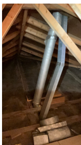
Kanaler fra nabo seksjon er ført opp på loftet
