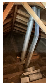
Kanaler fra naboleiligheten inn på loftet
