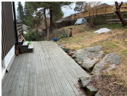
Fall på terreng mot bolig.
