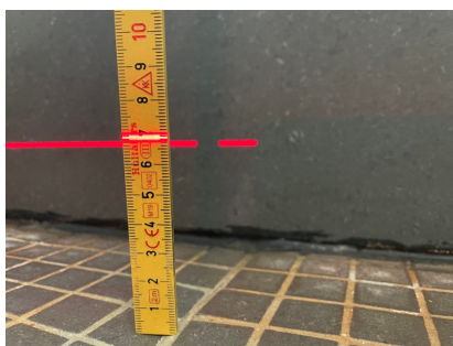
Bilde viser måling av høyde på gulv i hjørne av dusj
