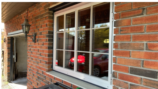
2 stk. aluminiumsvinduer i kjeller ved inngangsparti.
