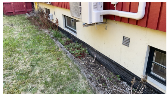
Synlig knotteplast mot vest og videre rundt huset.
