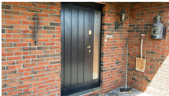
Inngangsdør fra byggeår.
