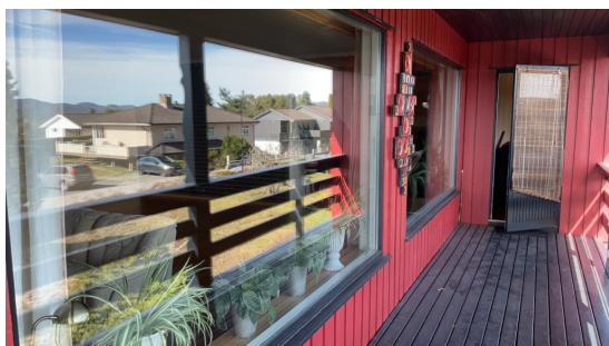
Store vindusflater i stue mot øst.
