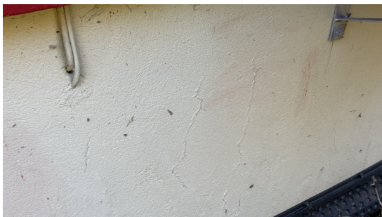
Bildene viser flere mindre riss i murpuss. Rissene vurderes å være av mindre betydning i selve pussen.
