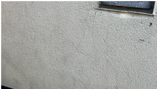
Bildene viser flere mindre riss i murpuss. Rissene vurderes å være av mindre betydning i selve pussen.
