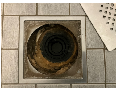
Oversiktsbilde av sluk
