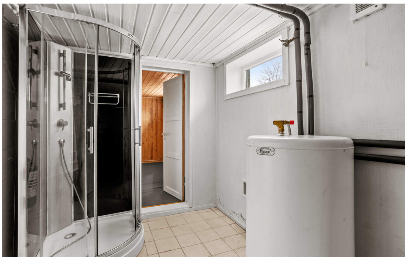
På vaskerommet er det satt inn dusjkabinett.
