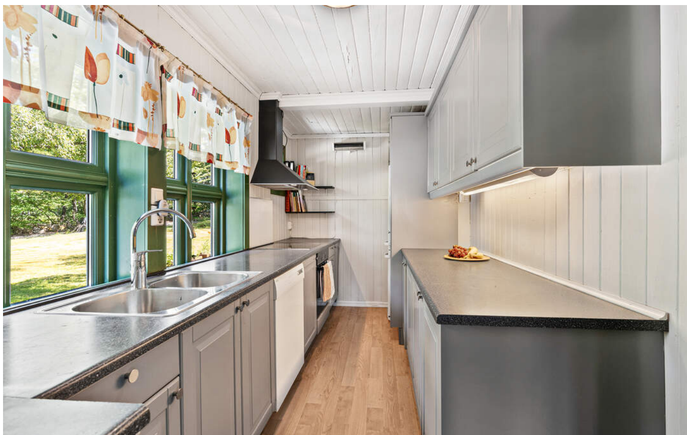
Innredning med profilerte fronter, laminatbenkeplate og kjøkkenventilator med avtrekk.
