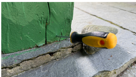
Bilde viser eksempel på bordkledning med råteskader, her ved svalgangen.
