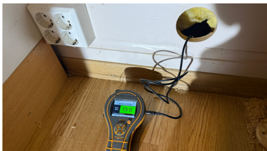
Bilde viser fuktmåling i påføret vegg mot terreng.
