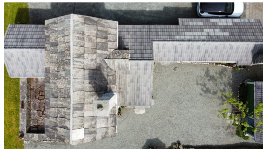
Oversiktsbilde fra drone som viser taktekingen.
