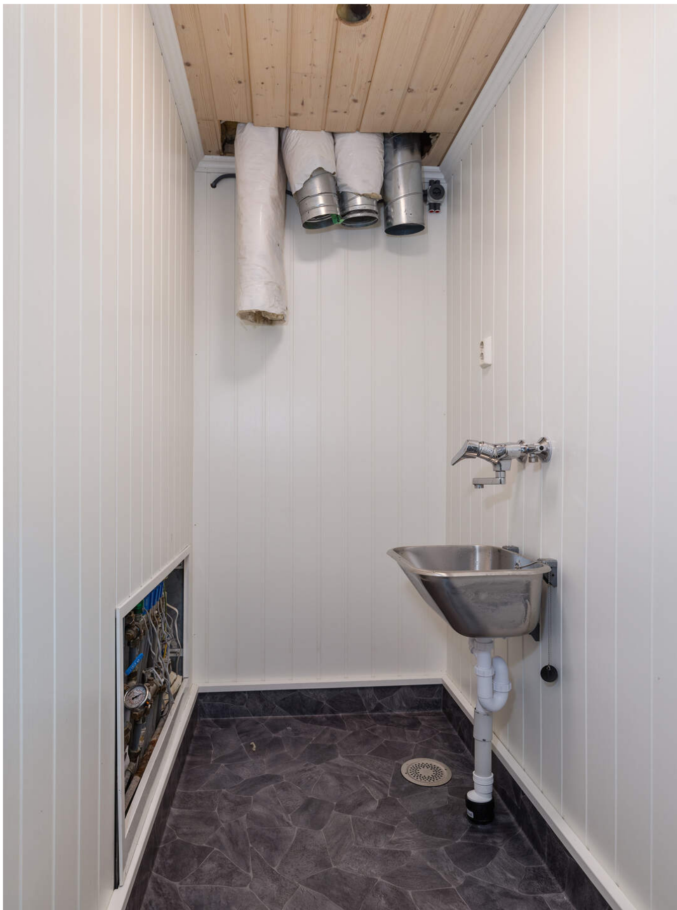
Praktisk vaskerom med utslagsvask og opplegg for vaskemaskin.
