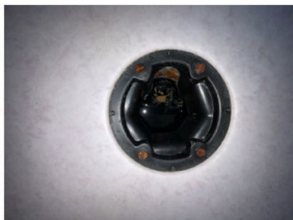
Plastsluk med synlig vinylbelegg.
